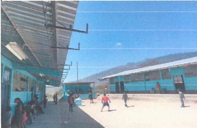
Foto 3: Remosamiento estructura de techo de patio
