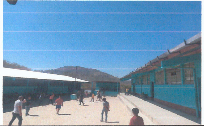
Foto 2: Mejoramiento canales de escuelas.
